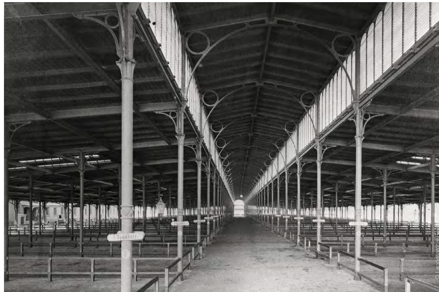
1890 Innenraum, ursprünglich nach allen Seiten offen
